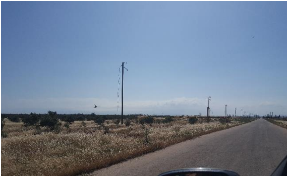
تأهيل الخدمات والبنى التحتية - الطريق إلى قطينة - 2020
